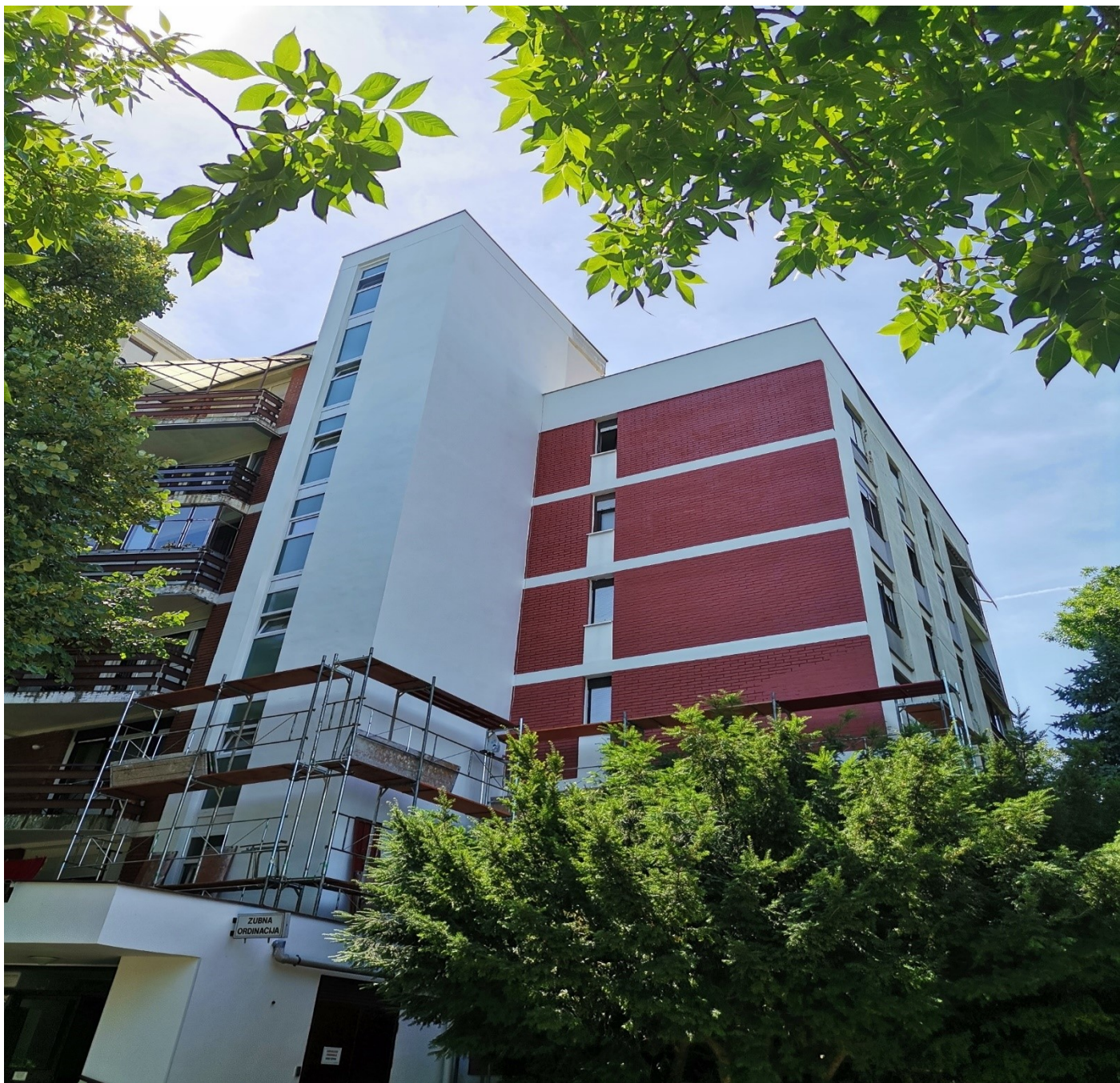
Bolšičeve 1 i 15 Zagreb fasada je samo djelomično termo-izolirana Bronya tj. nisu obuhvaćene sve strane
