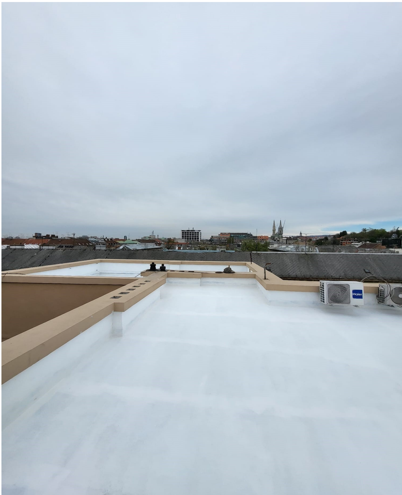
Bauerova 5. Zagreb , ravni krov hidroizolacija Bronya
