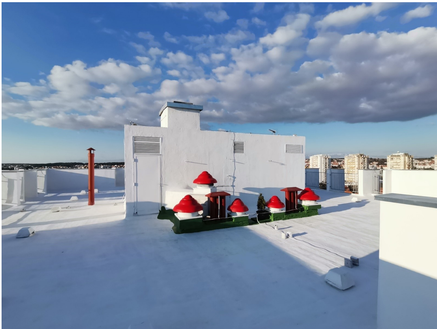
Zadar , Josipa bana Jelačića 4 , hidroizolacija ravnog krova
